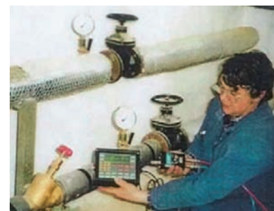
Рис. 4 Гидравлическая увязка с помощью компьютера HERZ
